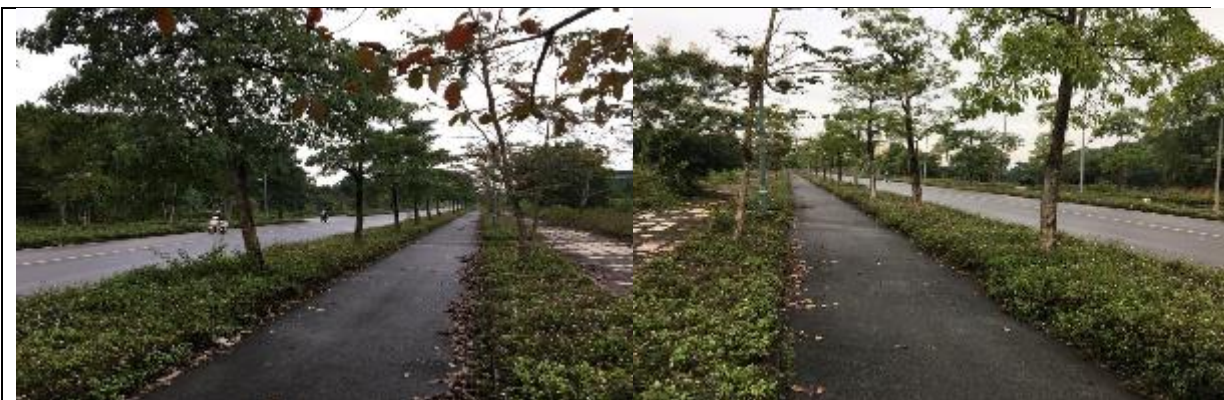
Hệ thống cống thoát nước mưa được xây dựng chìm ở phần vỉa hè
